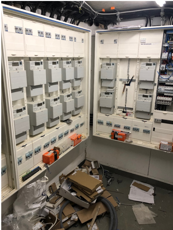
Die Abbildung zeigt den Verteilerbereich eines Hauses in der Entstehung
