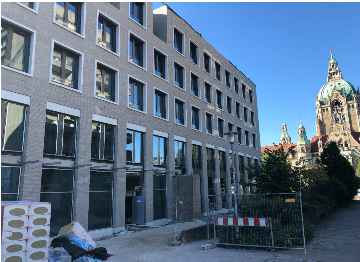
Die Abbildung zeigt einen Teil des Gebäudes im nahezu fertigen Zustand
